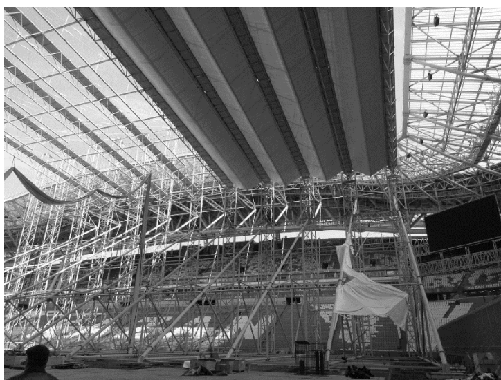
Рисунок 5. Монтаж стальных конструкций над стадионом «Казань-Арена» – подъем и монтаж тента (вид снизу).
