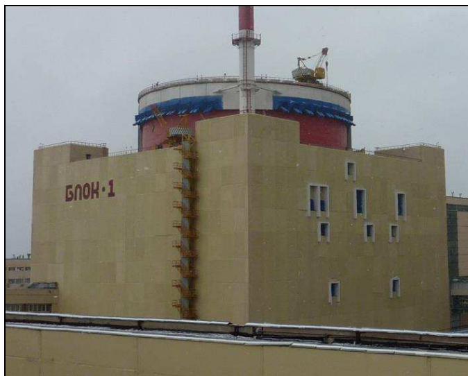
Рис. 1. Общий вид исследуемого сооружения
