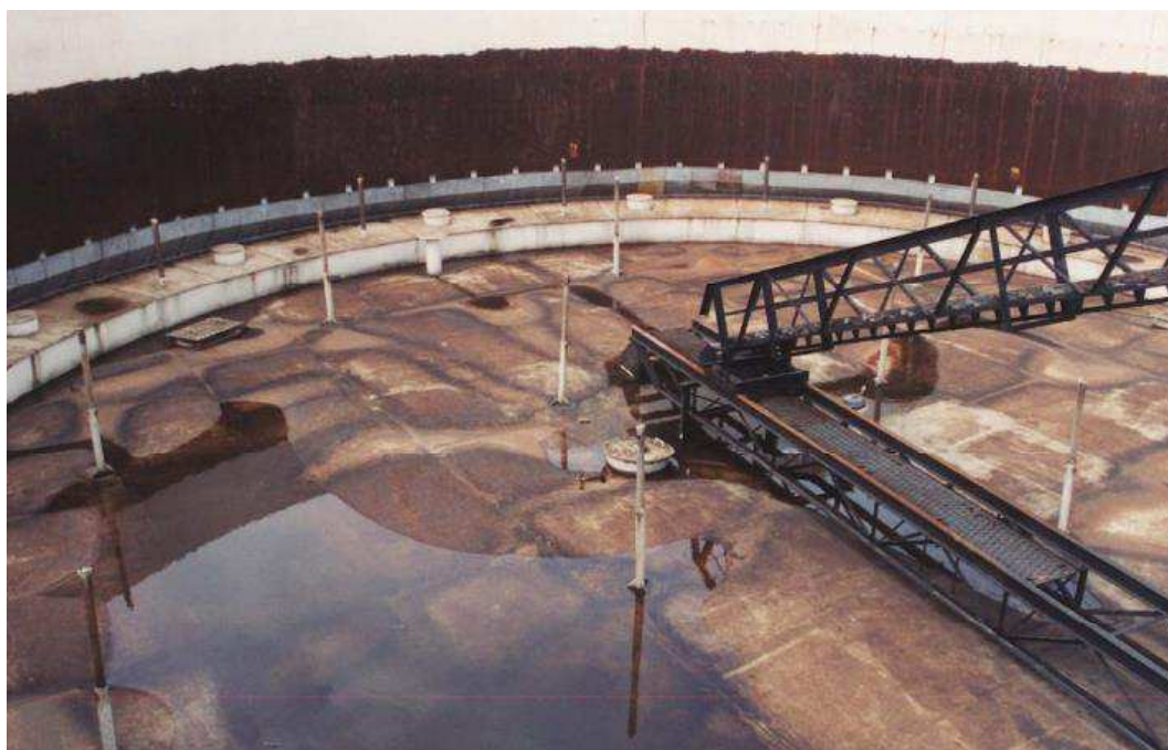
Рисунок 6. Резервуар с плавающей крышей – неразрушенное состояние.
