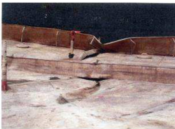
Рисунок 4. Потеря устойчивости понтона.
