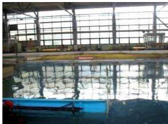
Рис. 1. Наполнение бассейна водой до проектного уровня
