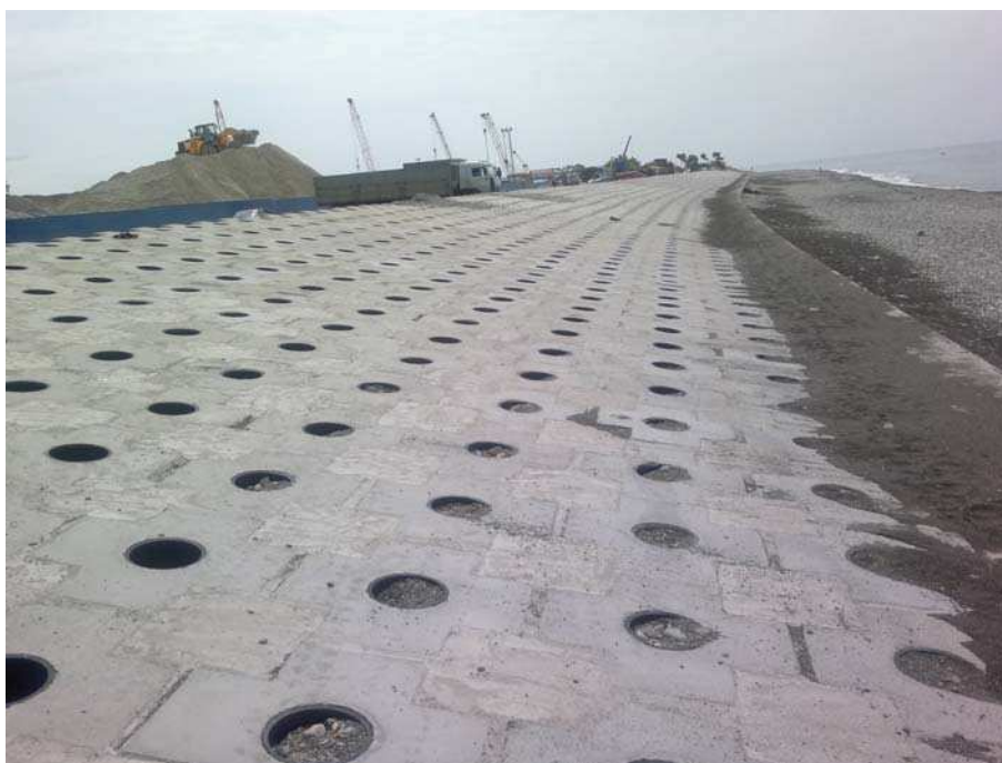
Рис.2. Крепление откоса проницаемыми блоками
