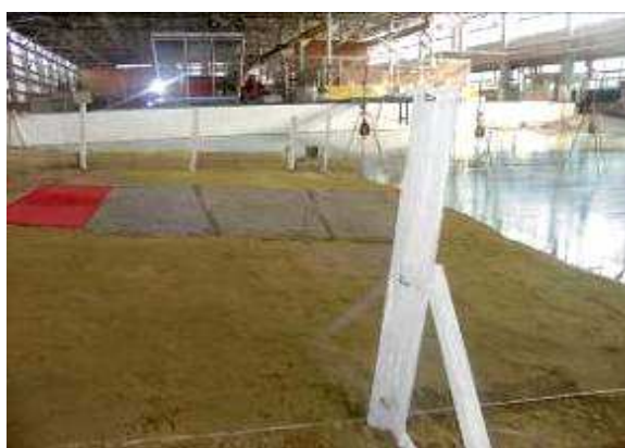
Рис. 3. Установка ограждающих панелей из органического стекла
