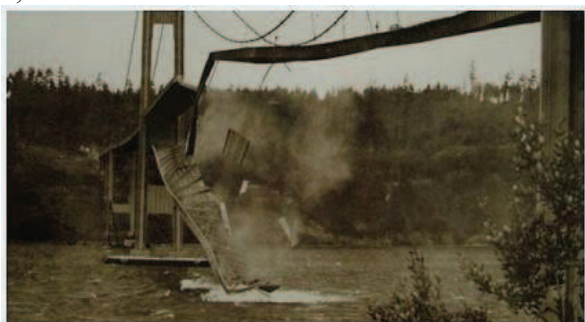
Рисунок 1. Обрушение Такомского моста.
